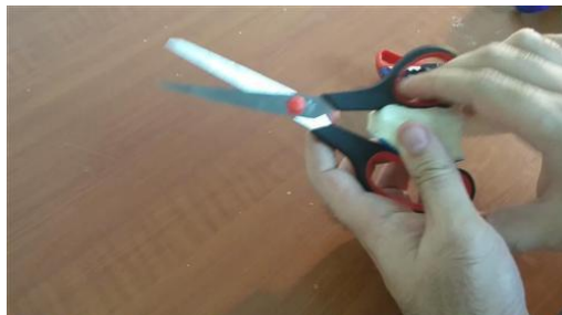
Colocación de la espuma.
